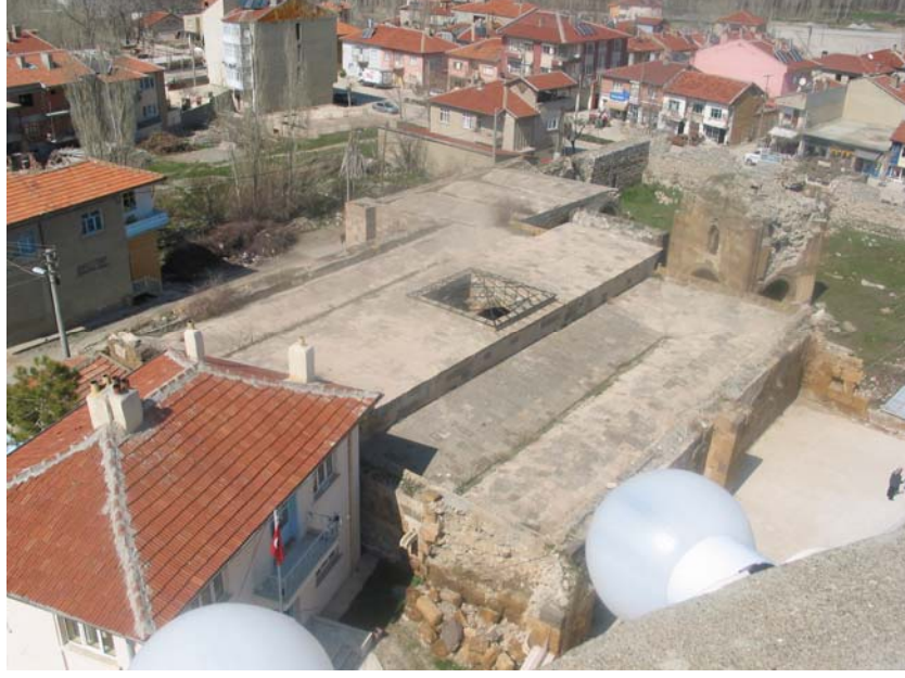
Şekil - 4. Kervansarayın güneybatı yönünde konumlanan İl Özel İdare binası.
