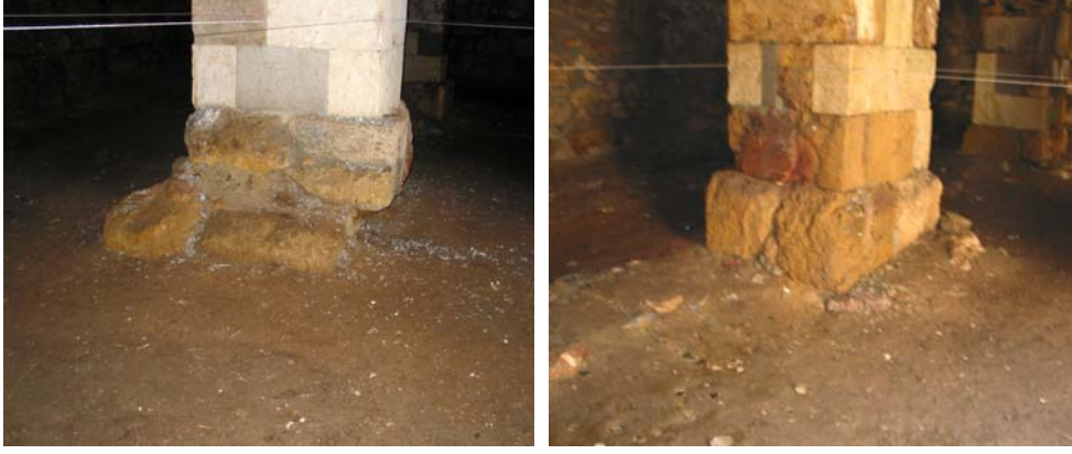
Şekil - 7. Barınak bölümünde kemer ayaklarındaki pabuçlar ve seki izleri.
