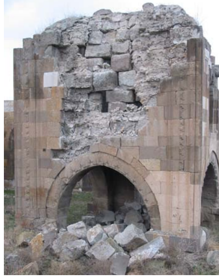
Şekil - 19. Mescidin güney cephesinden görünüm.
