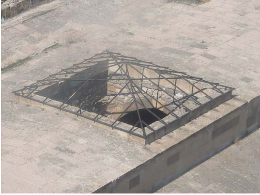
Şekil - 9. Barınak bölümünde aydınlık fenerine yapılan onarımlar.
