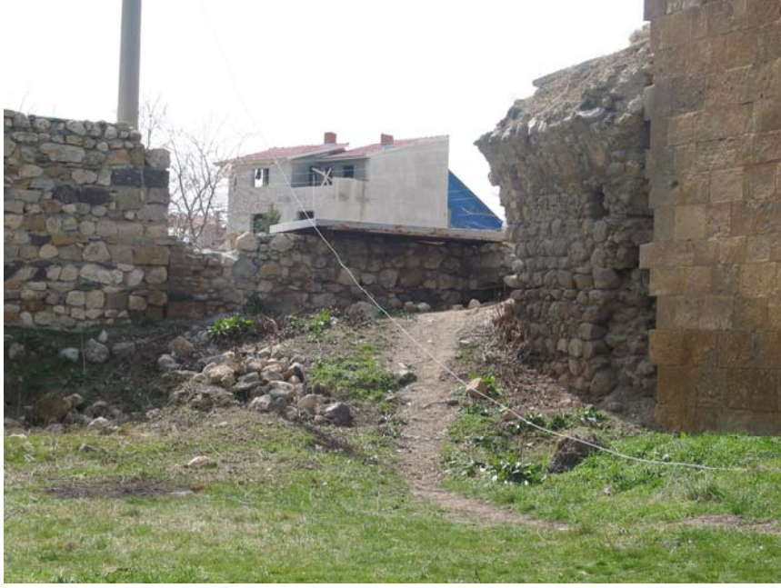
Şekil - 13. Avlunun güneydoğu duvarıyla, barınak bölümü duvarının yüzey oluşturduğu, varlığı kazılarla ortaya çıkan mekânın üst örtü izleri.
