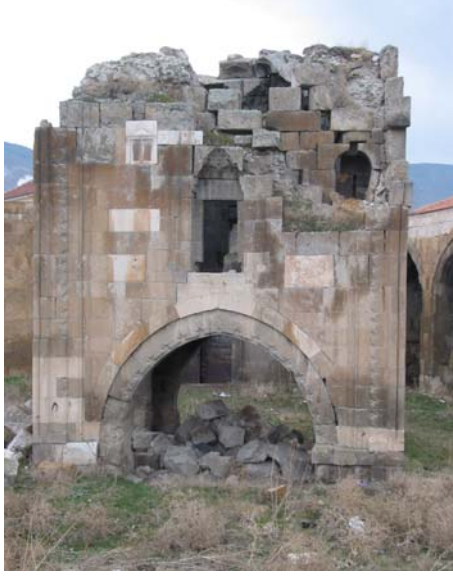
Şekil - 18. Mescidin doğu cephesinden görünüm.
